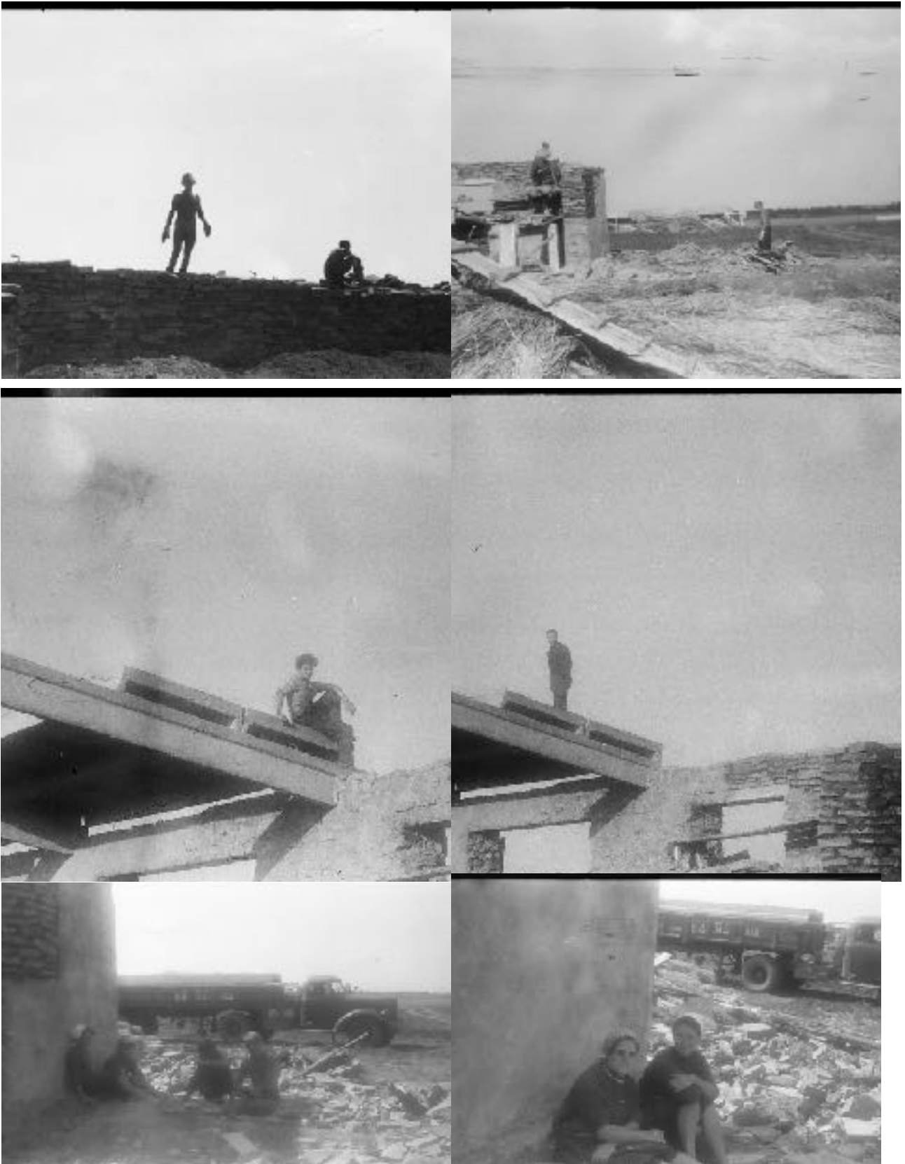
СТРОИТЕЛЬСТВО КОРОВНИКА В УСЛОВИЯХ КАЗАХСТАНСКОГО ЗНОЯ В ЛЕТНИЕ КАНИКУЛЫ - ДЕЛО ГЕРОИЧЕСКОЕ
